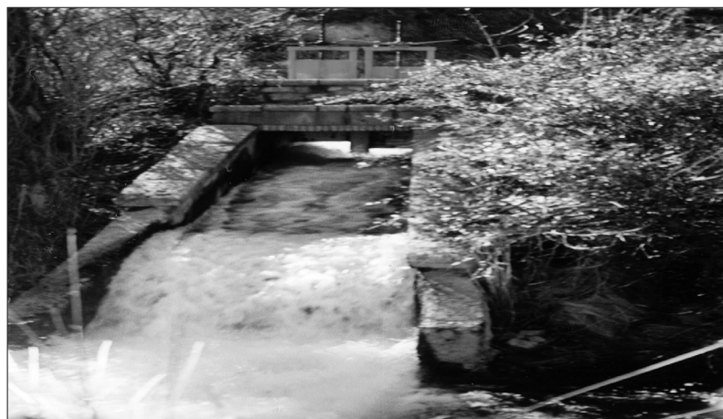
FIGURA 3. La fuente de Babor en la margen izquierda del río Mijares, unida mediante sifón por debajo del cauce a la fuente de Mas Royo en la margen derecha, en término de Mora de Rubielos, aportan conjuntamente cerca de 6 m 3 /s.
