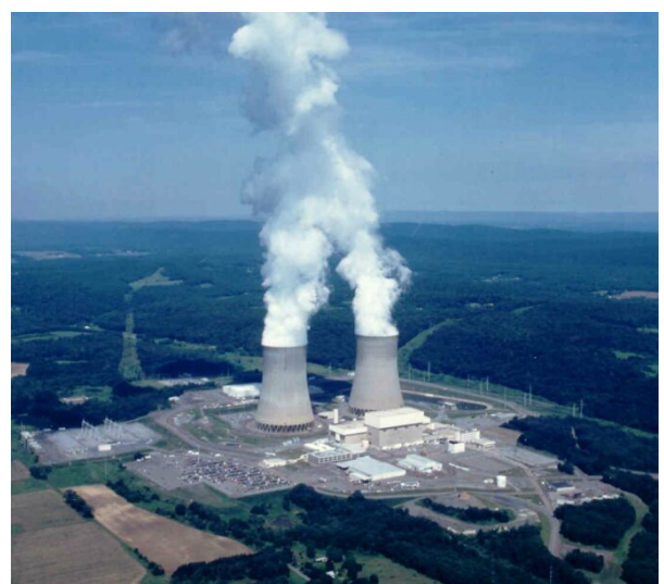
Planta de energía nuclear Susquehanna, con dos reactores de agua en ebullición ( BWR ). La refrigeración se realiza en circuito cerrado mediante dos torres de refrigeración que emiten vapor de agua.
