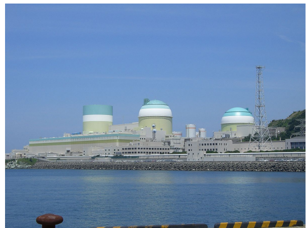
Central nuclear de Ikata, con tres reactores de agua a presión (PWR). La refrigeración se realiza mediante un intercambio de agua con el océano.
