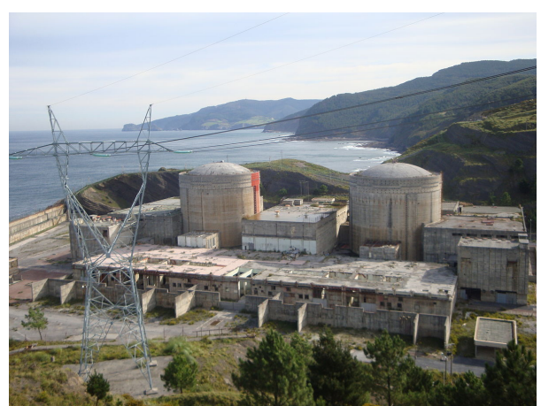
Central nuclear de Lemóniz (España) cuya puesta en marcha fue abandonada por la actividad terrorista de ETA
