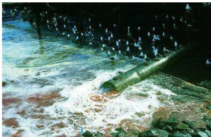
Figura 2. Descarga directa, sin pre-tratamiento, de los residuos orgánicos originados en una empresa cárnica (frigorífico). Foto gentileza de Eduardo Fernández y Daniel Forcelli.
