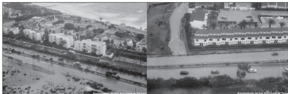
FIGURA 4. En la imagen de la izquierda se observa la inundación y los arrastres de materiales erosionados por las aguas de escorrentía en la carretera GC-500, cerca de la urbanización Bahía Feliz. En la fotografía de la derecha se muestra el desbordamiento del barranco de Las Burras que anega la misma vía y las urbanizaciones cercanas.
