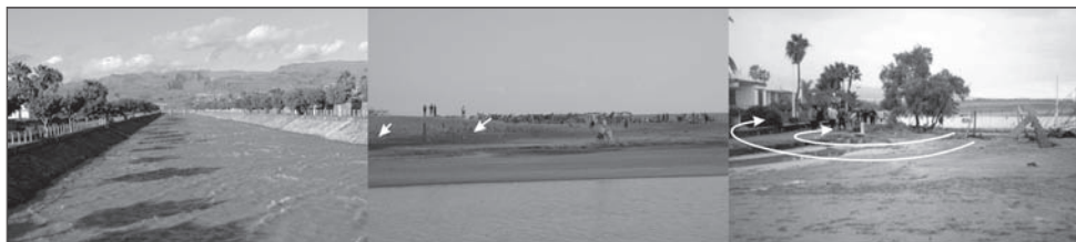
FIGURA 9. La fotografía de la izquierda muestra el canal construido sobre el barranco de Maspalomas durante las lluvias de enero de 2000. Las aguas, al llegar a la desembocadura, se encuentran con una laguna de agua salobre cuyo nivel asciende de forma repentina hasta las marcas indicadas con flechas en la imagen central, anegando los apartamentos cercanos.
