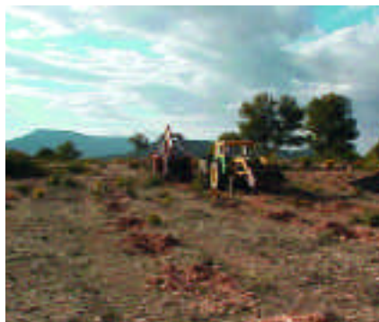
Maquinaria empleada en la aplicación superficial en zonas ZAU.
