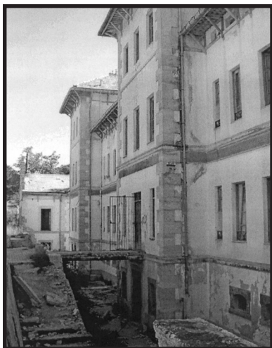
Vista del edificio principal y anexos
