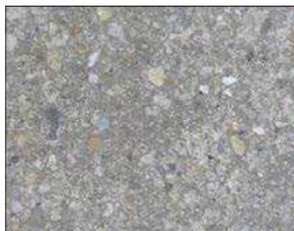
2/b ábra: 2005-ben CEM III/B 32,5 N-S cementtel készült takarmánytároló állapota 2010-ben (fényképezte: Kovács József DDC Kft.)
