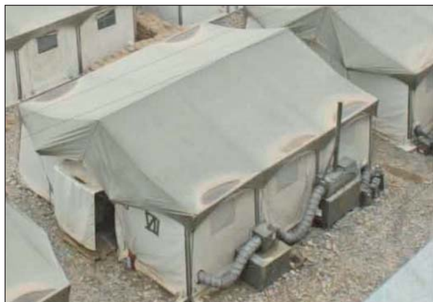
3. ábra. Német tábori sátor fűtési rendszere
