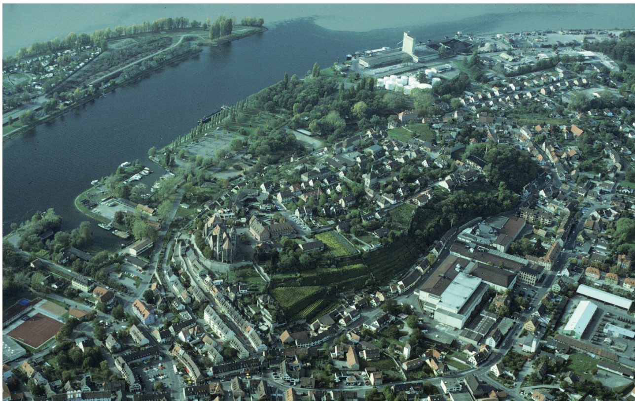
Figure 6.6. The Münsterberg of Breisach, seen from the southeast to the northwest, on the left side the Rhine (Landesamt für Denkmalpflege im RP Stuttgart/O.Braasch).
