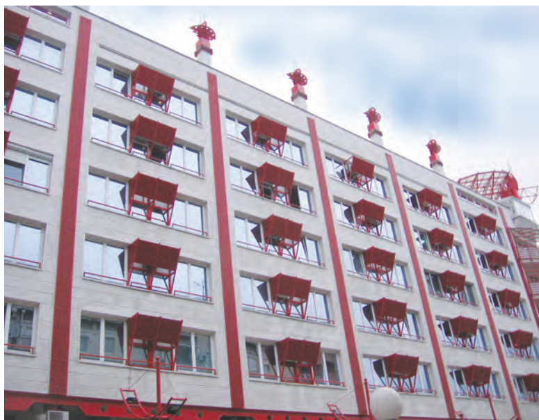
Сл. 34. YUBC – примери негативног коришћења испуста на фасади - детаљи (арх. Марио Јобст) Fig. 34. YUBC –examples of negative usage of façade drains – details (arch. Mario Jobst)
