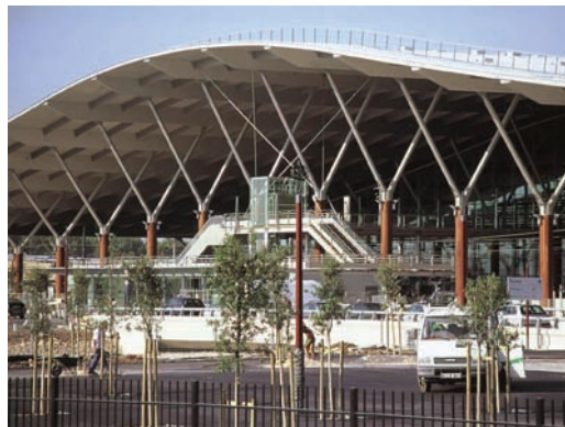
Сл. 20. Приступ из правца колосека Fig. 20. Rails direction entrance
