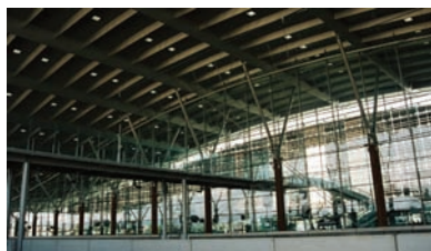
Сл. 21. Пешачка пасарела продире у објект Fig. 21. Pedestrian way permeates in object
