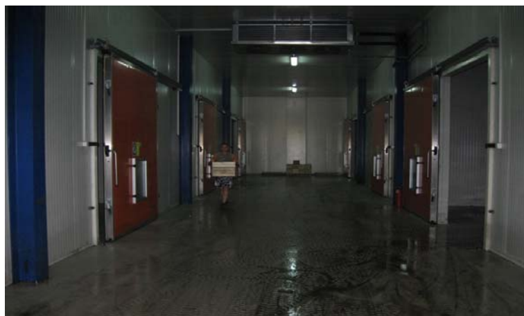
Slika 2. Unutrašnjost ULO hladnjače
