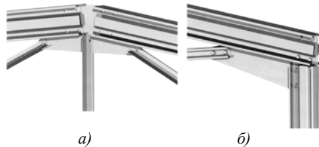
Слика 3. Везна плоча у слемenu (а) и веза рога и стуба (б)
