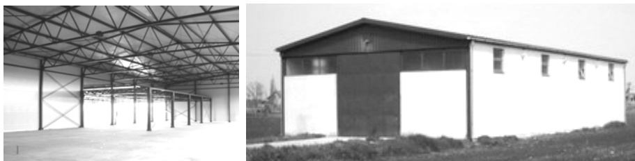
Слика 7. Изведене монтажне хале за складиштење пољопривредних производа
