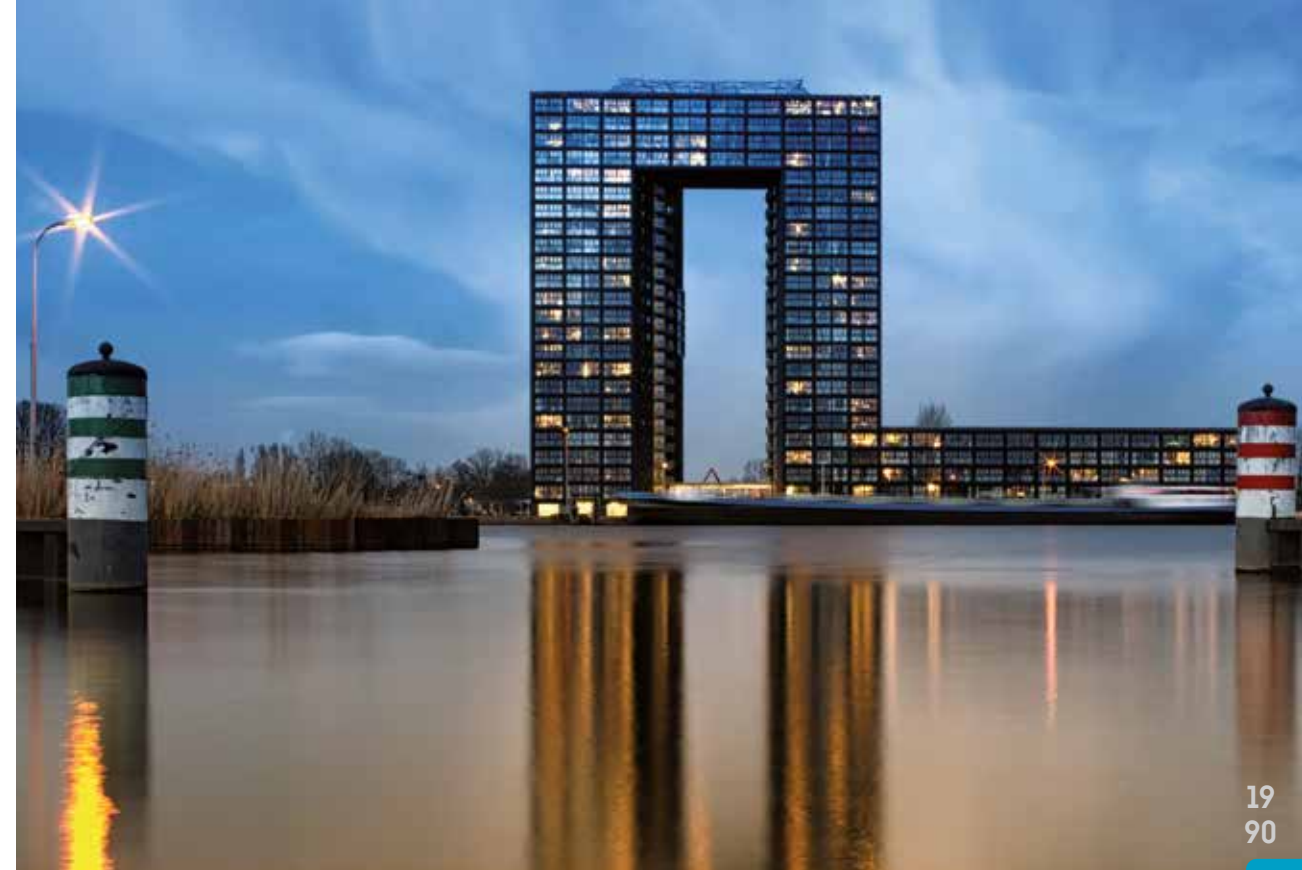
Tasmantoren (oorspronkelijk Waterknoop) in aanbouw, Regattaweg, Groningen
