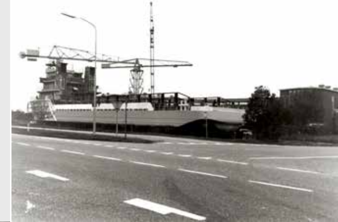
> Waterhuizen, Scheepswerf Pattje. Bouw bevoorradingsschip voor boortorens, ± 1975 - 80 chemische fabrieken bv
