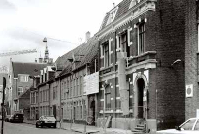
< Groningen, appartementen voor senioren op terrein voormalig Rode Weeshuis, restauratie en nieuw- en verbouw
