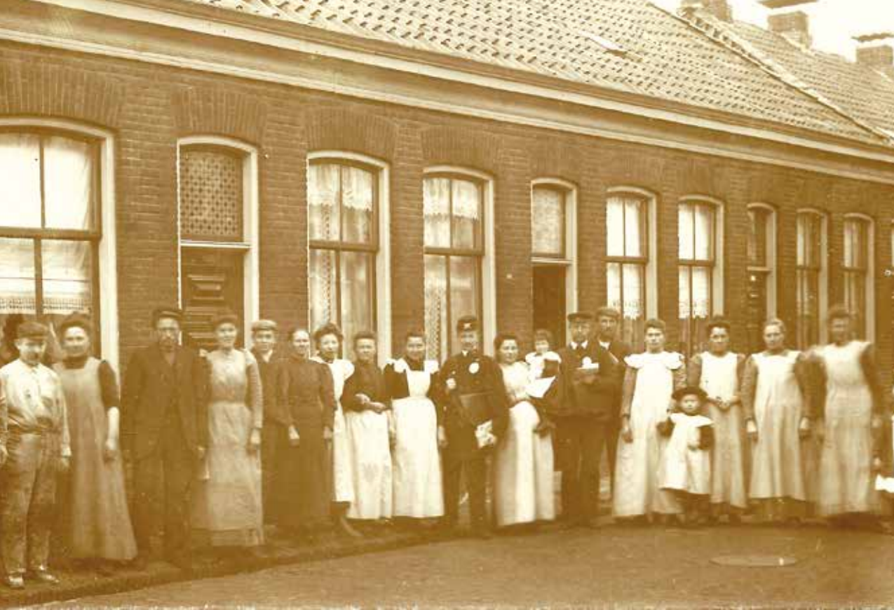
Warmoesstraat, Oosterpark Groningen
