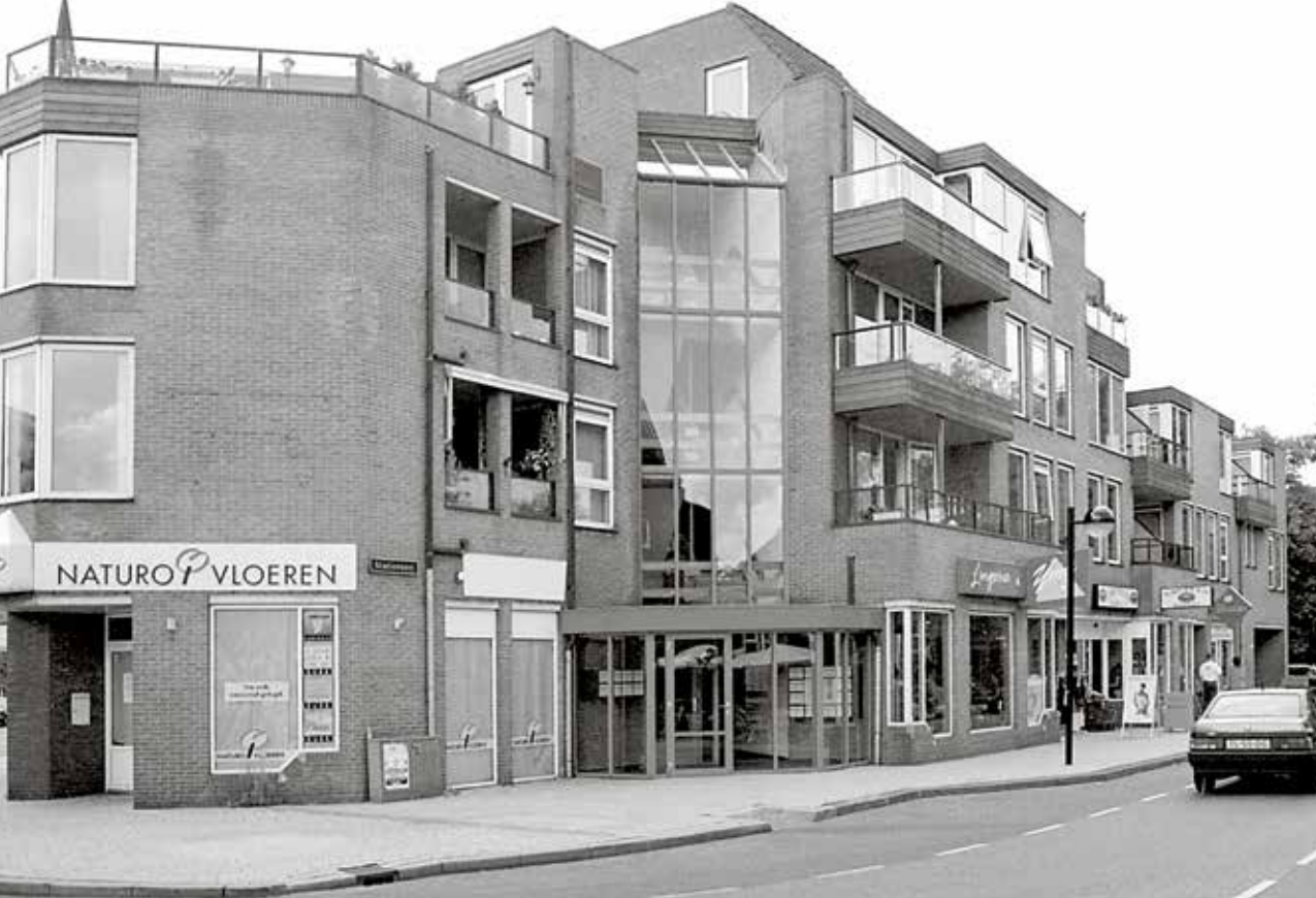
Type Postma, Stationsstraat, Emmen, gebouwd 1983
