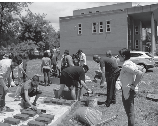
Figura 1: Trabajo teórico- práctico con tierras y adobes realizado en el laboratorio de materiales U. del Bío-Bío.
