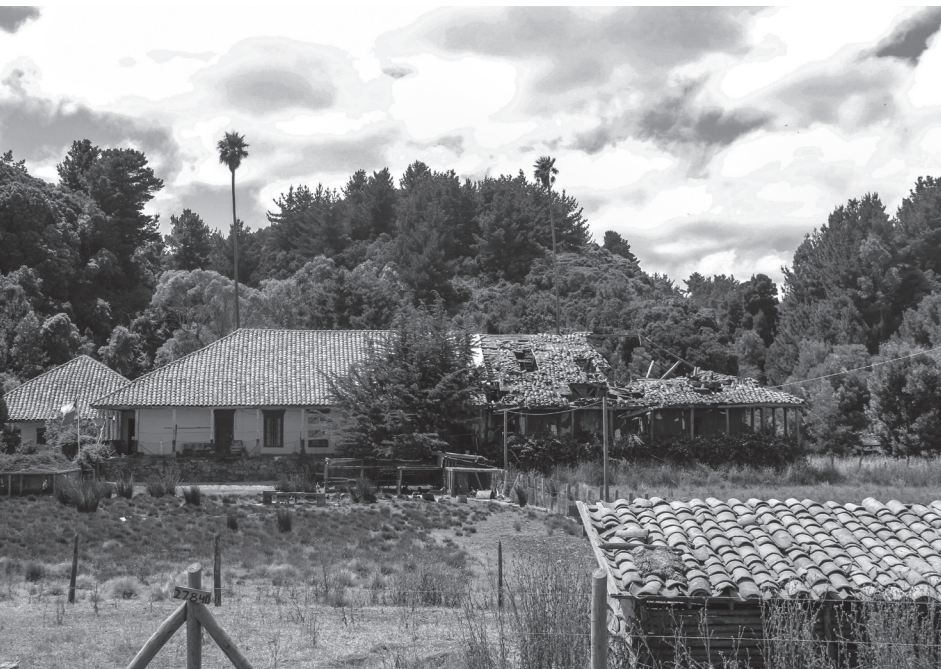
Figura 1. Casa en el epicentro del terremoto de 2010 (-35.951561, -72.743889), contraste entre la vivienda ocupada, restaurada, cuidada y el abandono. Trehuallemu, 2016. Fuente: Fotografía de Cristian Muñoz.
