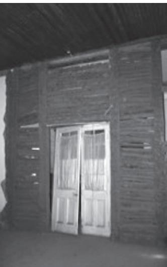
Figura 9: El terremoto del 27 de Febrero de 2010 (27F), dejó a la vista la composición de partes y piezas de los muros de tabiquería. Se aprecia que el concepto constructivo y estructural resuena con el concepto de la Ruca Mapuche.
