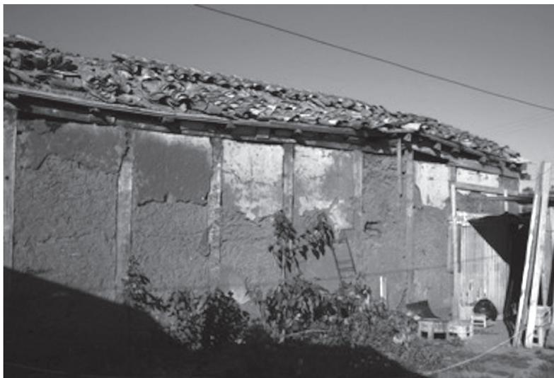
Figura 8: Muro perimetral de tabiquería de tierra construido a partir del sistema de postes de roble pellín empotrados al suelo, que forman la estructura fundamental de todo el sistema.
