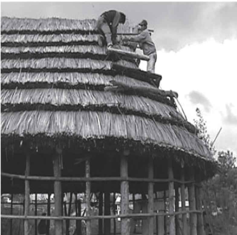
Figura 3: La construcción se basa en un sistema de postes empotrados a la tierra, los forman su estructura principal. No se emplean diagonales. Sus elementos secundarios van siendo más ligeros mientras más arriba se coloquen. Fuente: <http://www.plataformaarquitectura.cl/cl/02-333115/arquitectura-vernacula-la-ruca-araucana-en-el-sur-de-chile/52f1479fe8e44e0b6d00008f-arquitectura-vernacula-la-ruca-araucana-en-el-sur-de-chile-foto>
