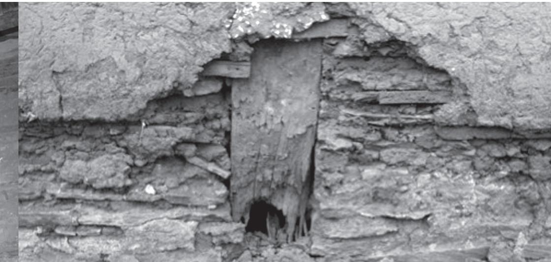
Figura 11: En otra vivienda –ya deteriorada– se combina un basamento de piedra loja y tierra que se interrumpe para dar paso el empotramiento de los postes estructurales de roble.
