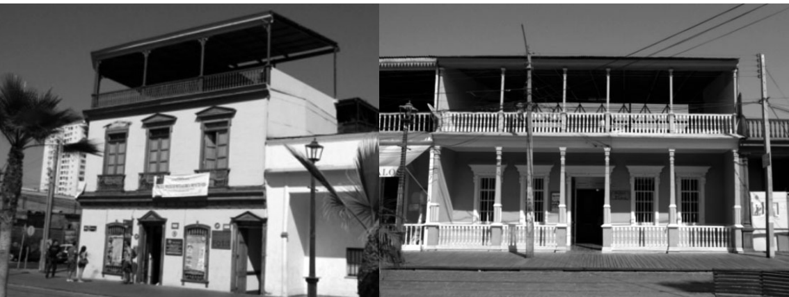
Figura 1: Vivienda Iquique. La tipología de vivienda de diversas ciudades portuarias chilenas, donde es posible identificar elementos que se trasladan de manera literal (puertas, ventanas, tecnologías) pero con innovaciones morfológicas, que dan cuenta del lugar donde se ubican. En este caso en el puerto de Iquique se incorpora una terraza superior cubierta con un sombreadero, adaptada al clima local.
