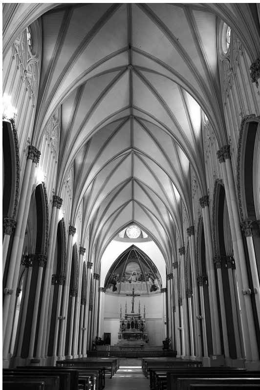
Figura 3: Iglesia de los Doce Apóstoles. Valparaíso. La solución tecnológica que adoptan las bóvedas de crucerías en estilo góticas de este templo se debe a la tradición constructiva local, los materiales disponibles y la sismicidad propia de nuestro suelo.
