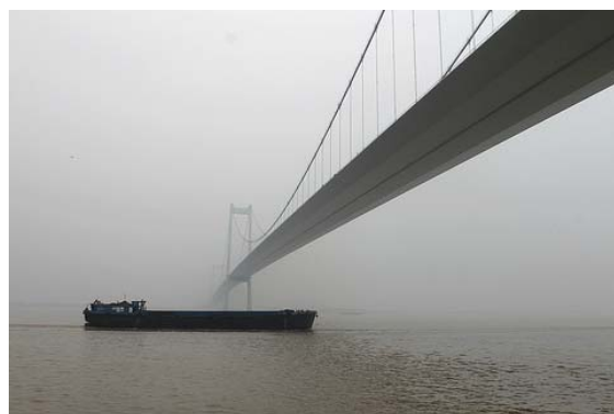
Figura 1: Puente Taizhou, China.
