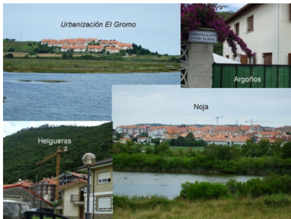
Figure 4. Les nouvelles constructions résidentielles / New residential constructions
