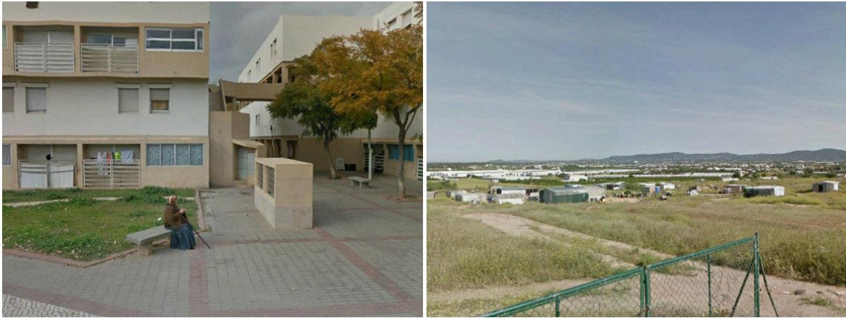
Figure 22 - "Bairro da Av. Cidade Hayward " and “Bairro Cerro do Bruxo” Faro, 2014, respectively
