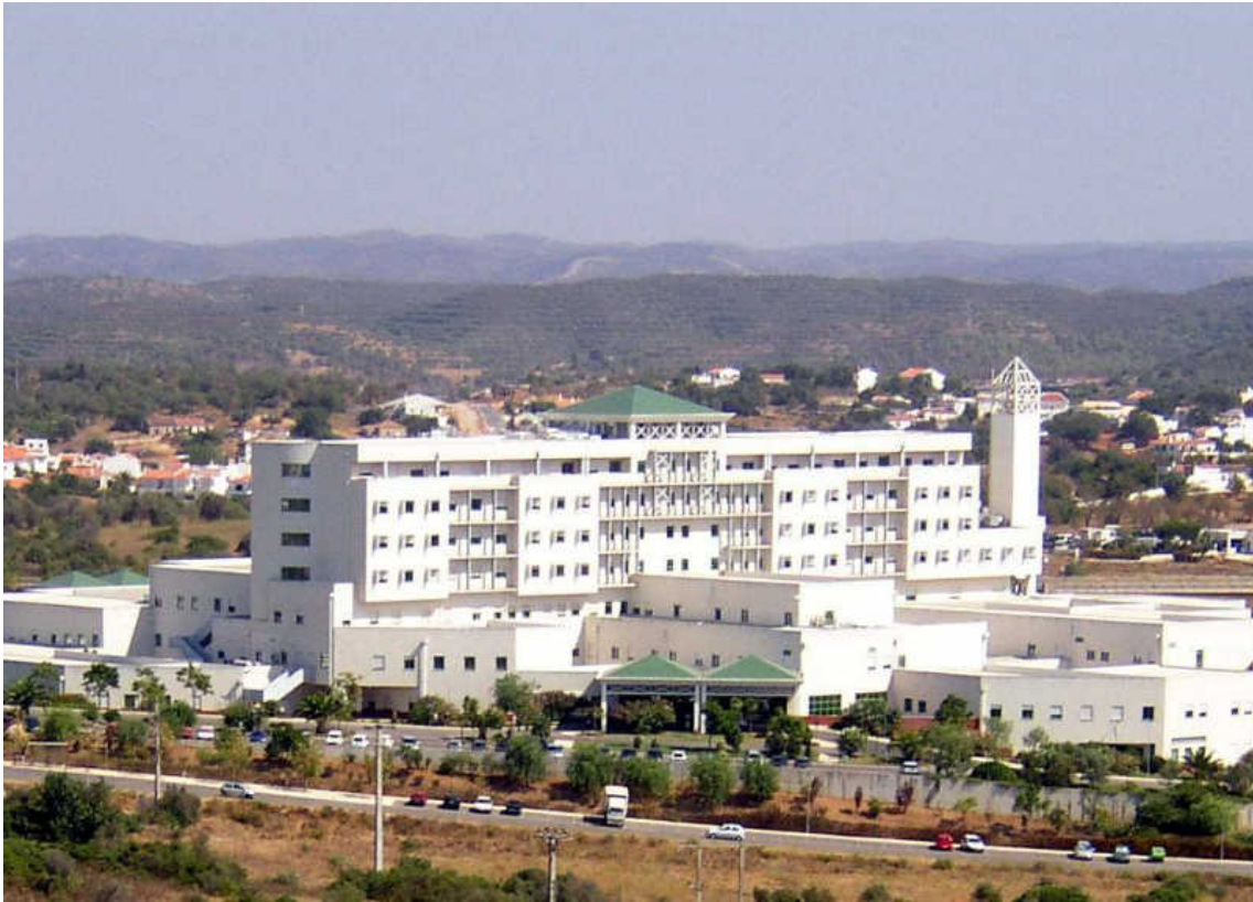
Figura 1 - Unidade Hospitalar de Portimão. Fonte: http://www.solinderg.com/kolmeks_obras.html
