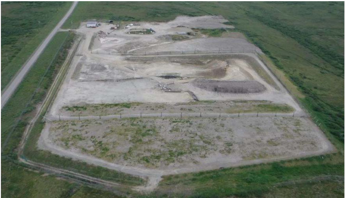
Figure 1: Nome Beam Road Landfill. Photo courtesy City of Nome
