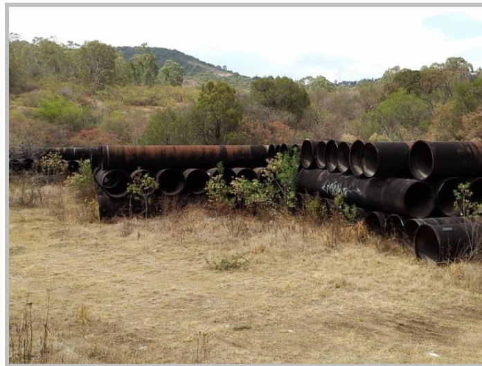
Figura 3.54. Tubería destinada para la protección del canal. Fuente: Trabajo de campo.
