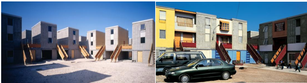
Imagen 02. Progresividad en la Quinta Monroy
