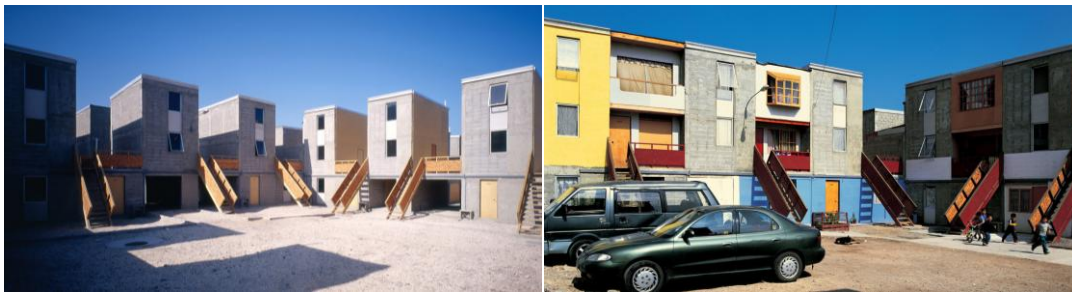
Imagen 04. Progresividad en la Quinta Monroy
