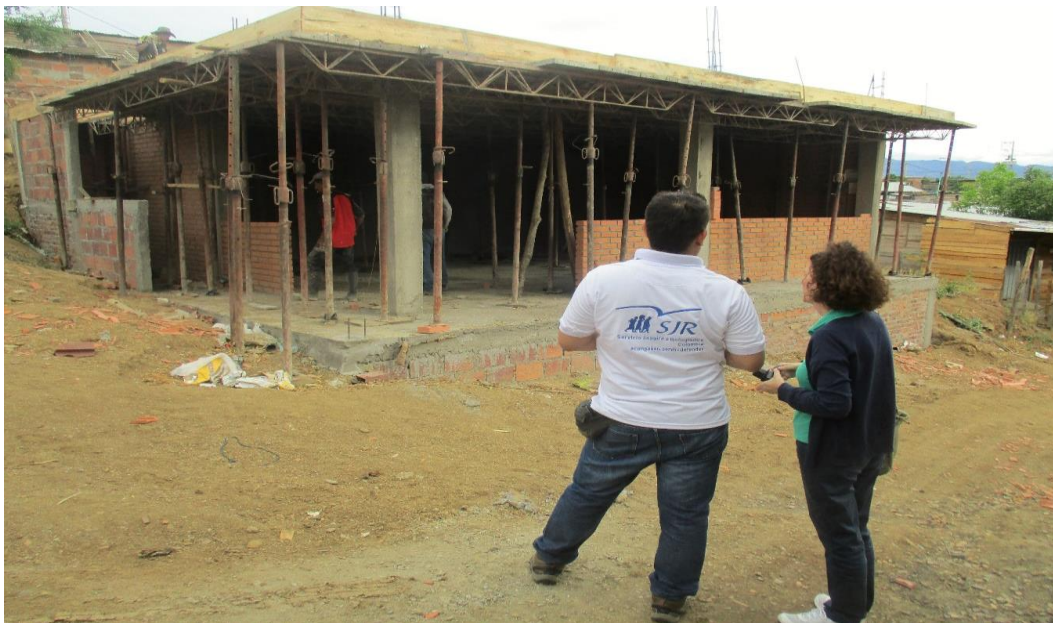
Imagen 10. Primera etapa de construcción del salón comunitario de convivencia y paz (Archivo Servicio Jesuita de Refugiados, 2016).
