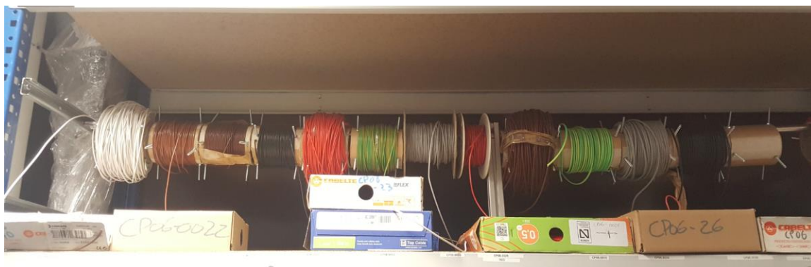
Figura 40 - Distribuição de fios elétricos no armazém da EVOLEO
