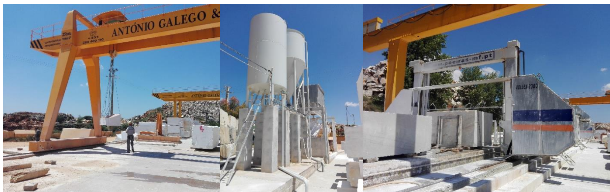
Figura 5-17 - Pórticos para transporte de blocos e parque de blocos à esquerda, no meio a unidade de tratamento de águas e lamas e à direita um dos monofios para corte do bloco.
