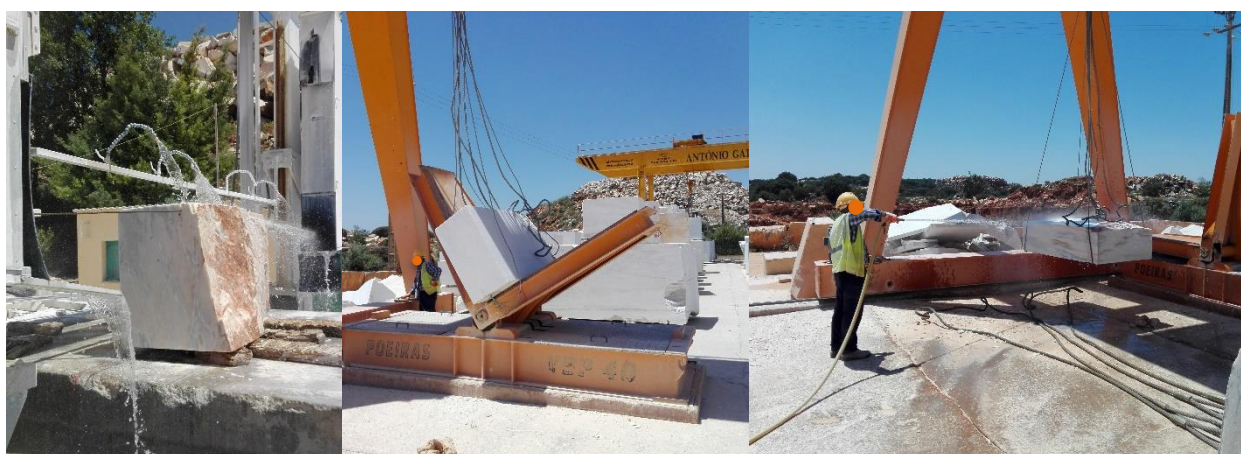
Figura 5-22 - Sexto corte aplicado no bloco EXT4 e a utilização do vira blocos e respetiva limpeza do bloco.
