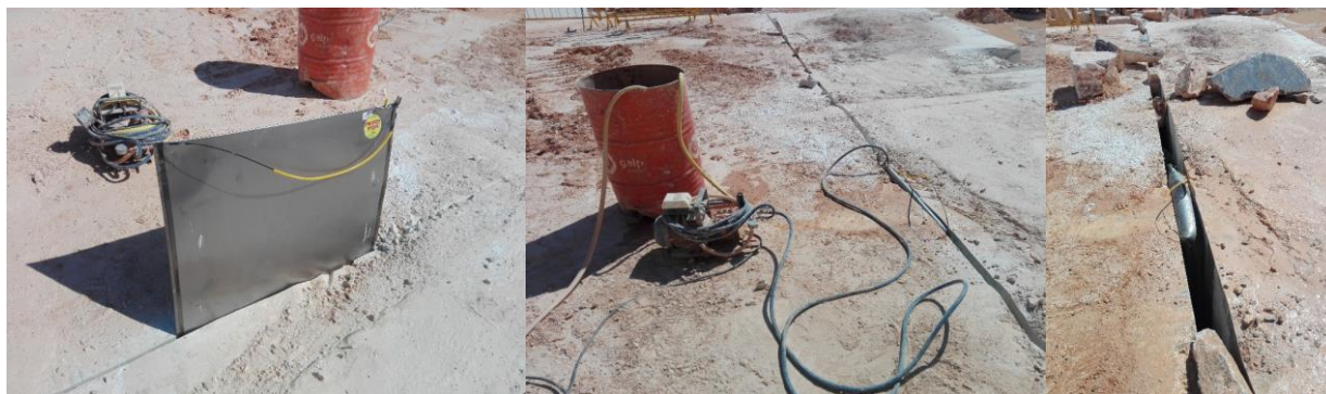
Figura 5-11 - Demonstração das várias etapas da operação de enchimento dum colchão de água.
