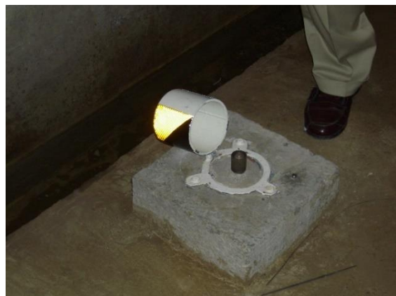
Figura 12 - Cabeça de extensómetro para medição. Fonte: Própria.
