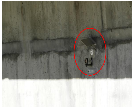
Figura 2 - Ponto objeto materializado no paramento de jusante da barragem por um alvo refletor. Fonte: Própria.
