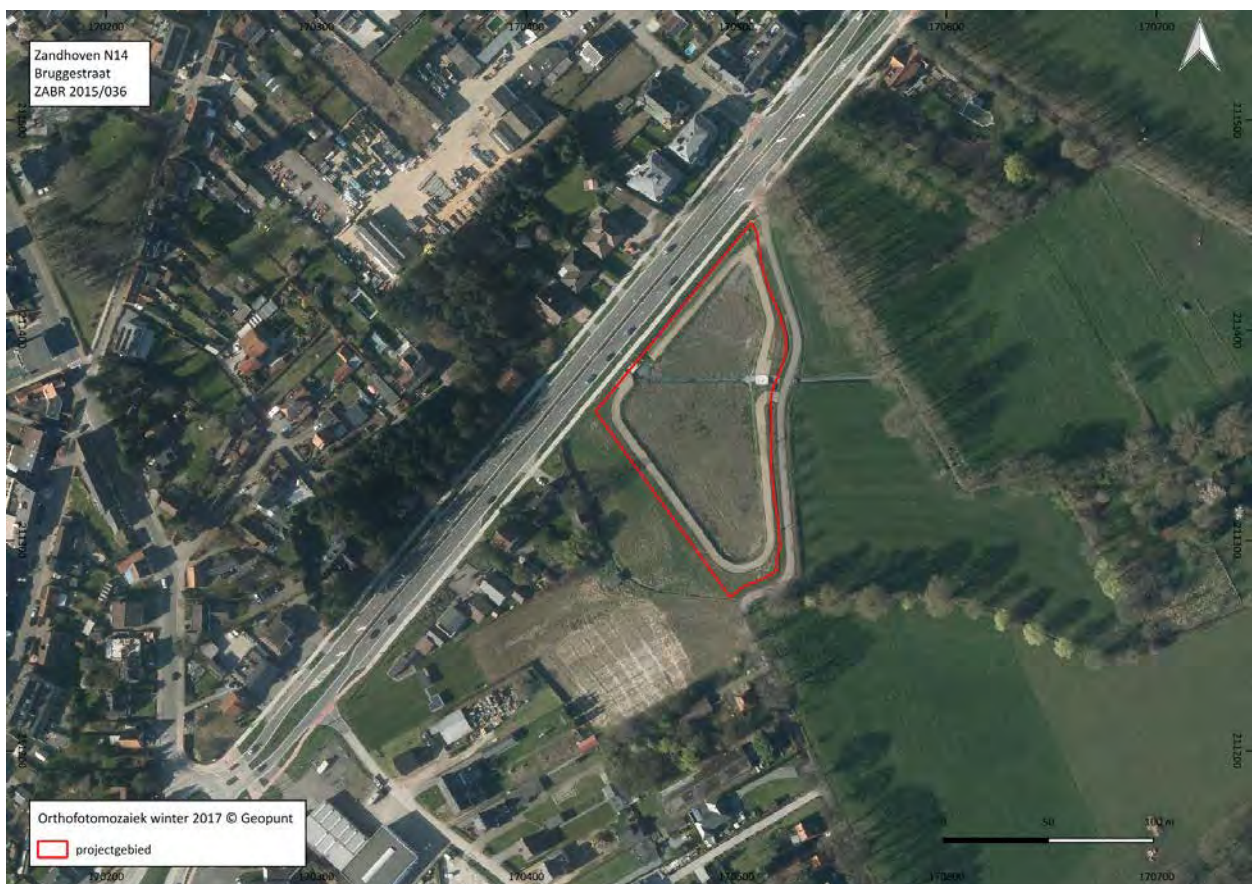
Fig.83 Situering van de site Bruggestraat op de orthofotomosaïek middenschalg winter 2017 na de bouw van het bufferbekken. © Geopunt
