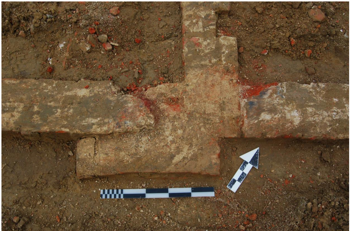
Foto 2: bouwnaad (links van de noordpijlpunt) en verschil in mortel in de fundering van het oostelijke gebouw.
