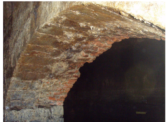
Foto 13. De natuurstenen zijn in het onderste deel van de muren onregelmatig gekapt. Daarboven zijn de zandstenen vlakker afgewerkt. (foto MoWa)
