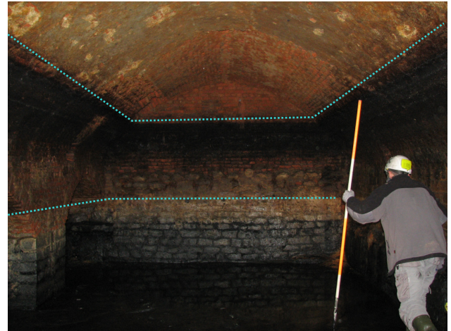
Foto 11 en 12. Bakstenen gewelf met zicht op de noordelijke en de zuidelijke korte zijden. Het huidige en een ouder waterniveau tekenen zich af door respectievelijk een donkere verkleuring (bovenaan) en een lichte aflijning (blauwe puntlijnen). (Foto MoWa)
