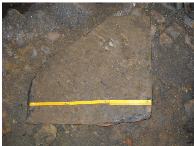
Foto 3. Fragment van de dekplaat in blauwe hardsteen waarmee het mangat (M11) was afgedekt. (foto JB/NR)
