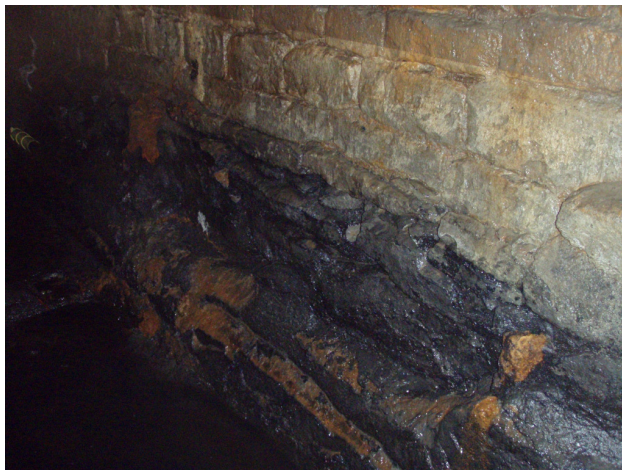
Foto 13. De natuurstenen zijn in het onderste deel van de muren onregelmatig gekapt. Daarboven zijn de zandstenen vlakker afgewerkt. (foto MoWa)
