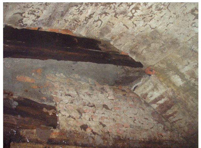
Foto 18 en 19. Houten balken en een betonnen balk in de noordelijke toegang. (foto's MoWa)
