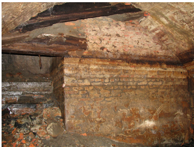
Foto 18 en 19. Houten balken en een betonnen balk in de noordelijke toegang. (foto's MoWa)
