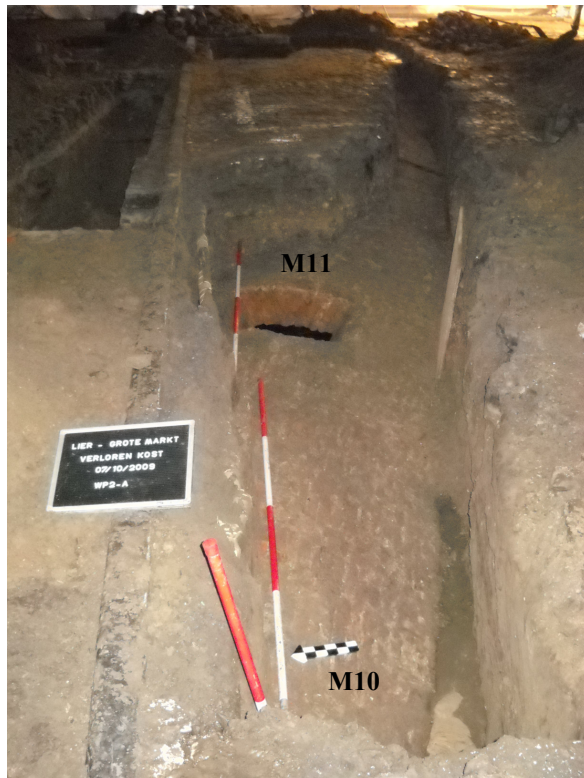
Foto 1 en 2. Mangat (M11) in het bakstenen gewelf van de Verloren Kost. (foto JB/NR)
