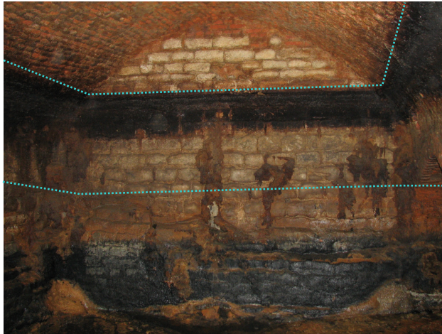
Foto 11 en 12. Bakstenen gewelf met zicht op de noordelijke en de zuidelijke korte zijden. Het huidige en een ouder waterniveau tekenen zich af door respectievelijk een donkere verkleuring (bovenaan) en een lichte aflijning (blauwe puntlijnen). (Foto MoWa)
