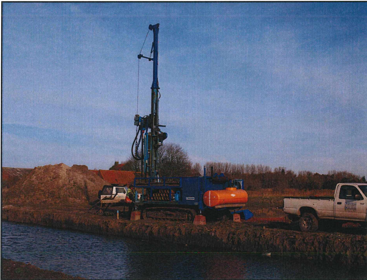
Figuur 5: Mechanische boring.
