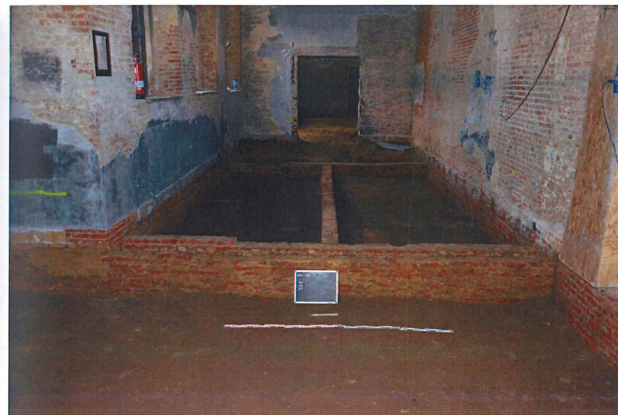
Fig. 4.7: Zicht op het westelijke deel van de zuidelijke pandgang.
