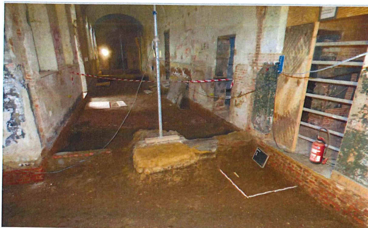
Fig. 4.5: Zicht op de fundering van de afgebroken (19 de -20 ste -eeuwse) binnenmuur.
