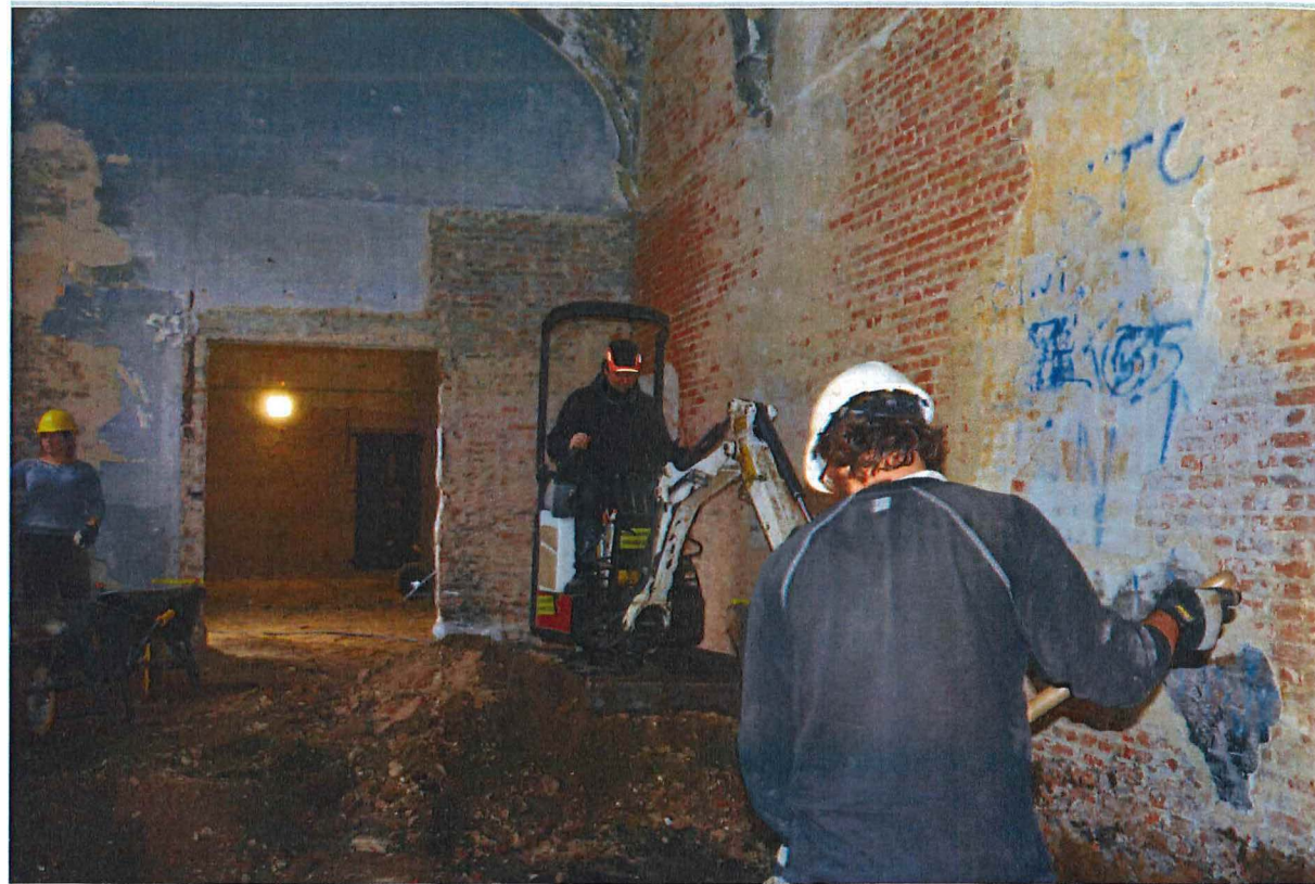
Fig. 3.1: Machinaal verdiepen in het kloosterpand.
