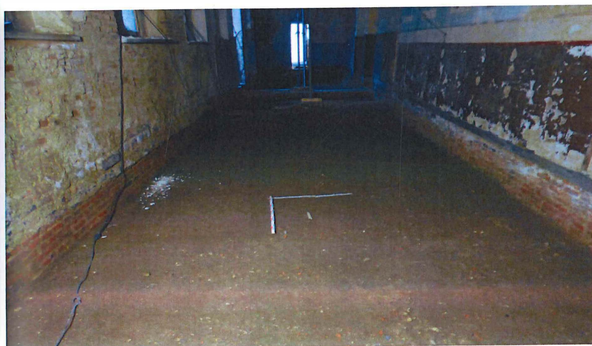
Fig. 4.13: Zicht op de oostelijke pandgang na het verwijderen van de vloer in grafstenen.
