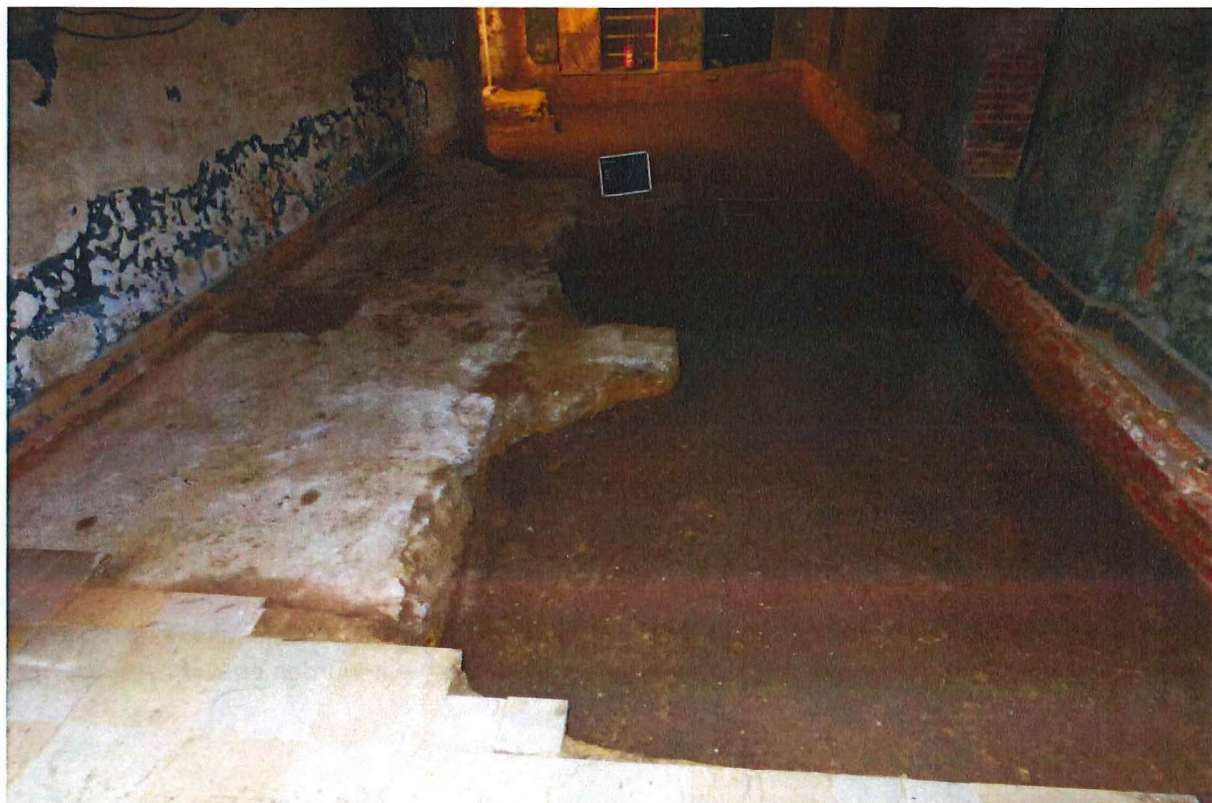
Fig. 3.2: Betonnen fundering in de noordelijke pandgang.
