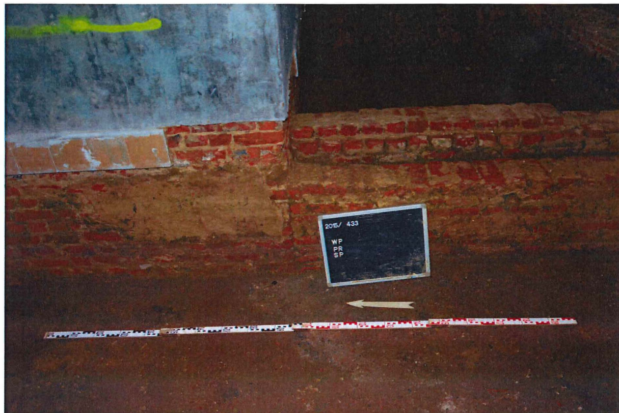
Fig. 4.8: De muur van het kloosterpand staat niet in verband met de bakstenen muur.
