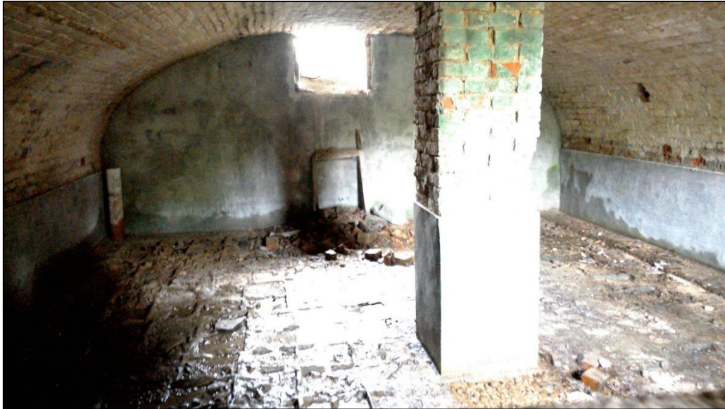
Figuur 39: Overzichtfoto kelder 3
