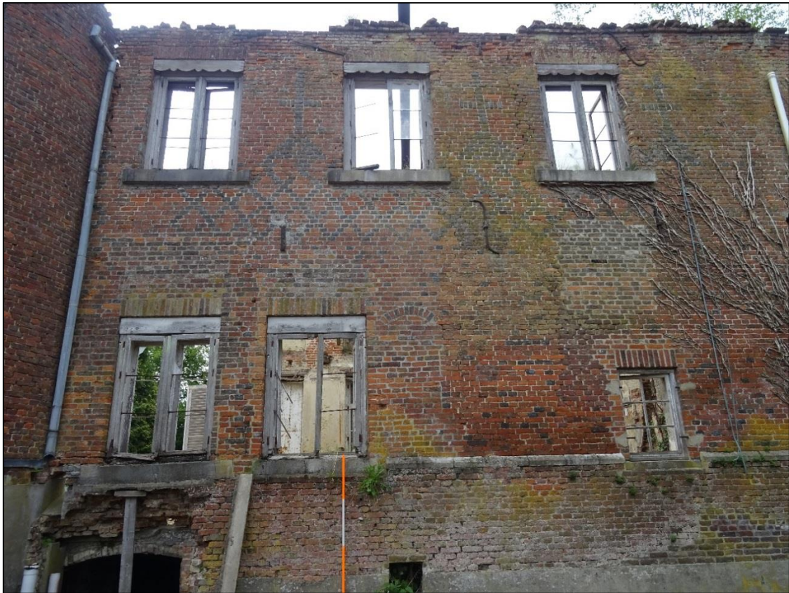
Figuur 51: overzichtfoto achtergevel met muurankers en metseltekens
