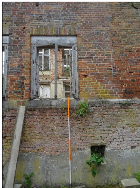
Figuur 48: 16-17 de eeuw toegemetsd venster met ontlastingsboog aan de achtergevel
