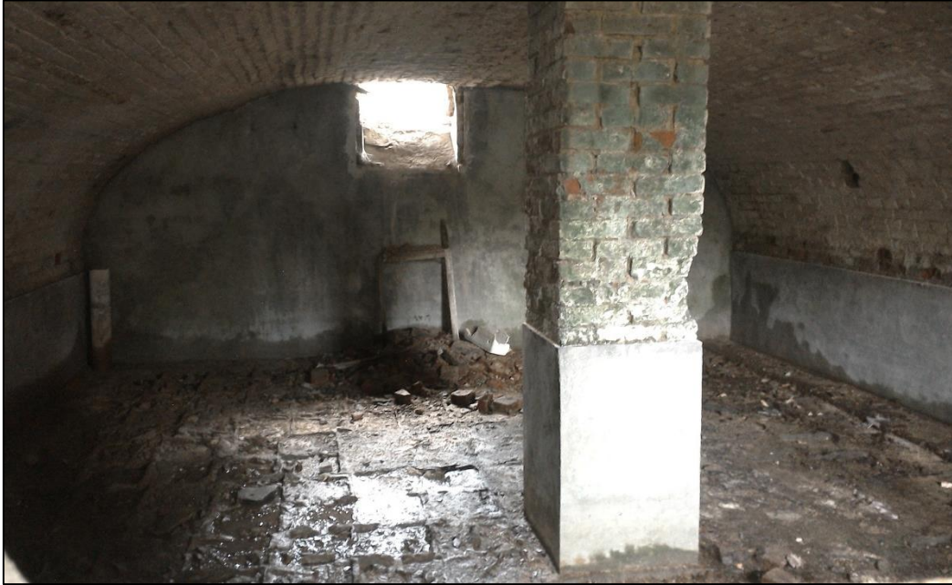
Figuur 30: zicht op de centrale kelder
