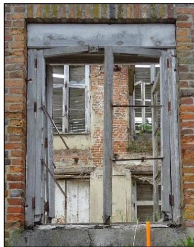
Figuur 49: 19 de eeuwse raamprofiel achtergevel
