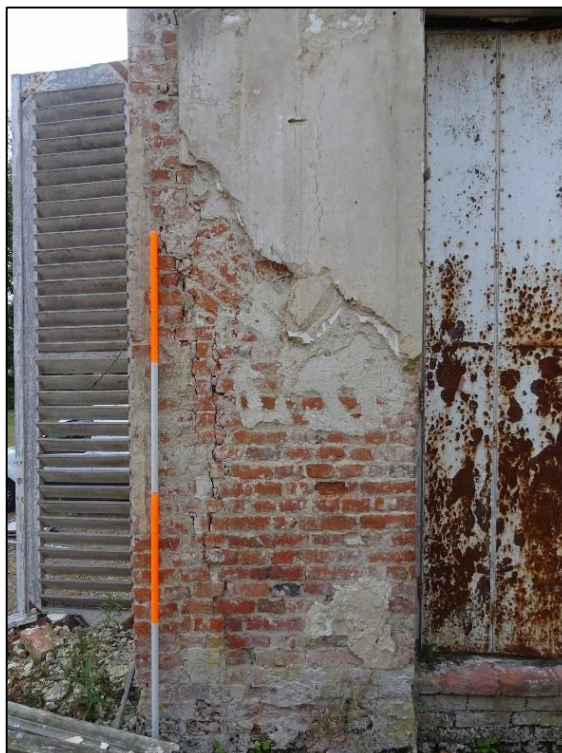
Figuur 55: Kalklagen interieur
