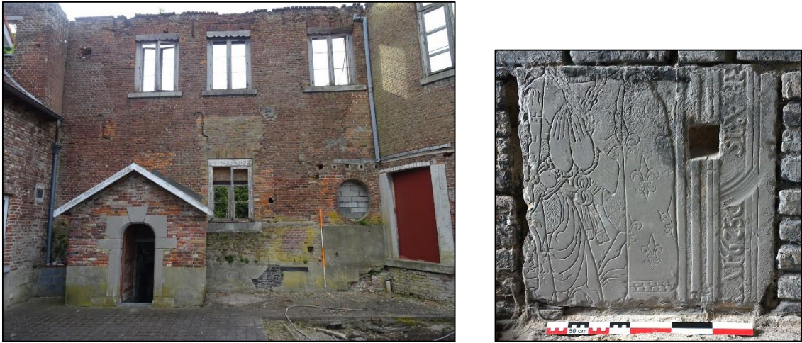
Figuur 50: noordelijke keldertoegang en gerecupereerde en ingemetselde grafplaat
