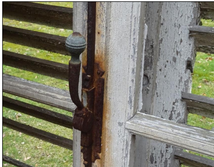
Figuur 43: balustervormige hefboom
