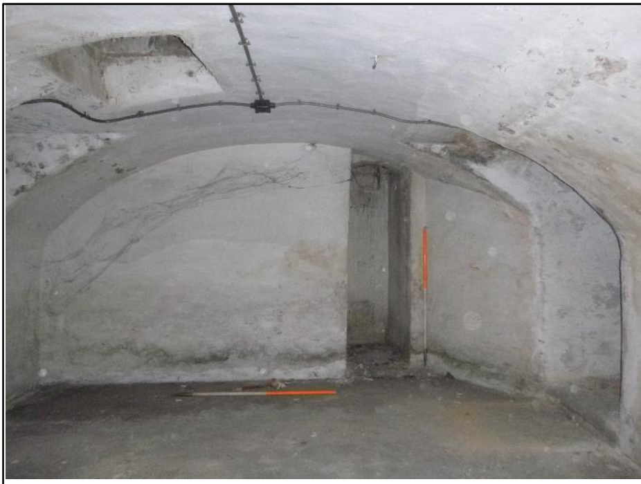
Figuur 15: Kelderruimte met bakstenen overwelling (ABO nv)
