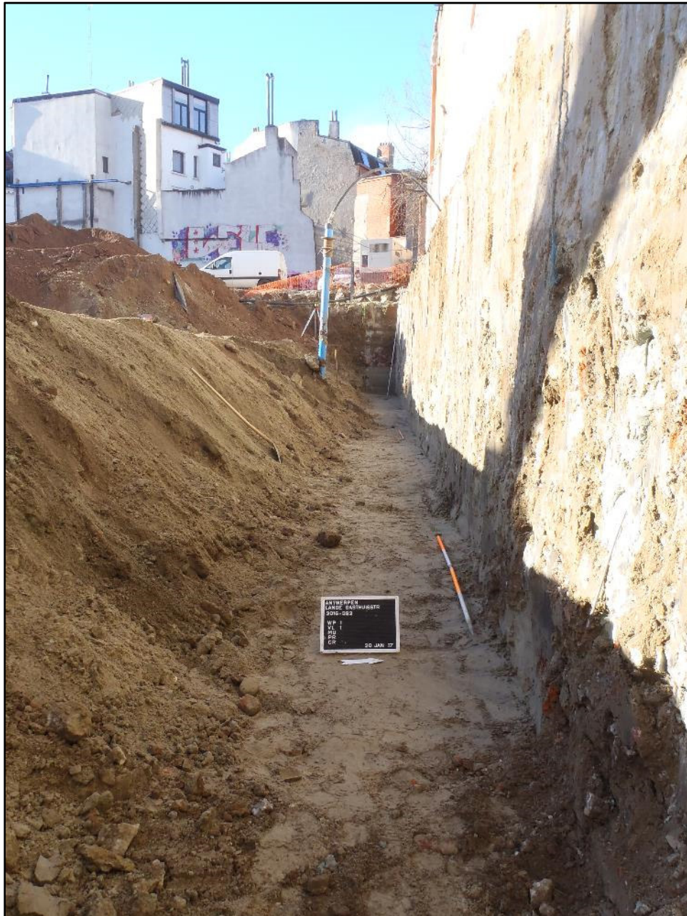
Figuur 39: Begeleiding uitgraving Soilmixwanden (ABO nv)
