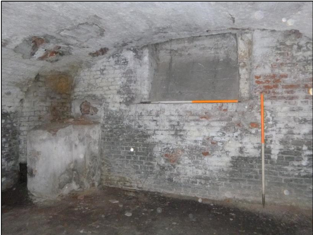
Figuur 17: Kelderruimte met stortkoker voor bulkgoederen (kolen) langs de straatzijde (ABO nv)
