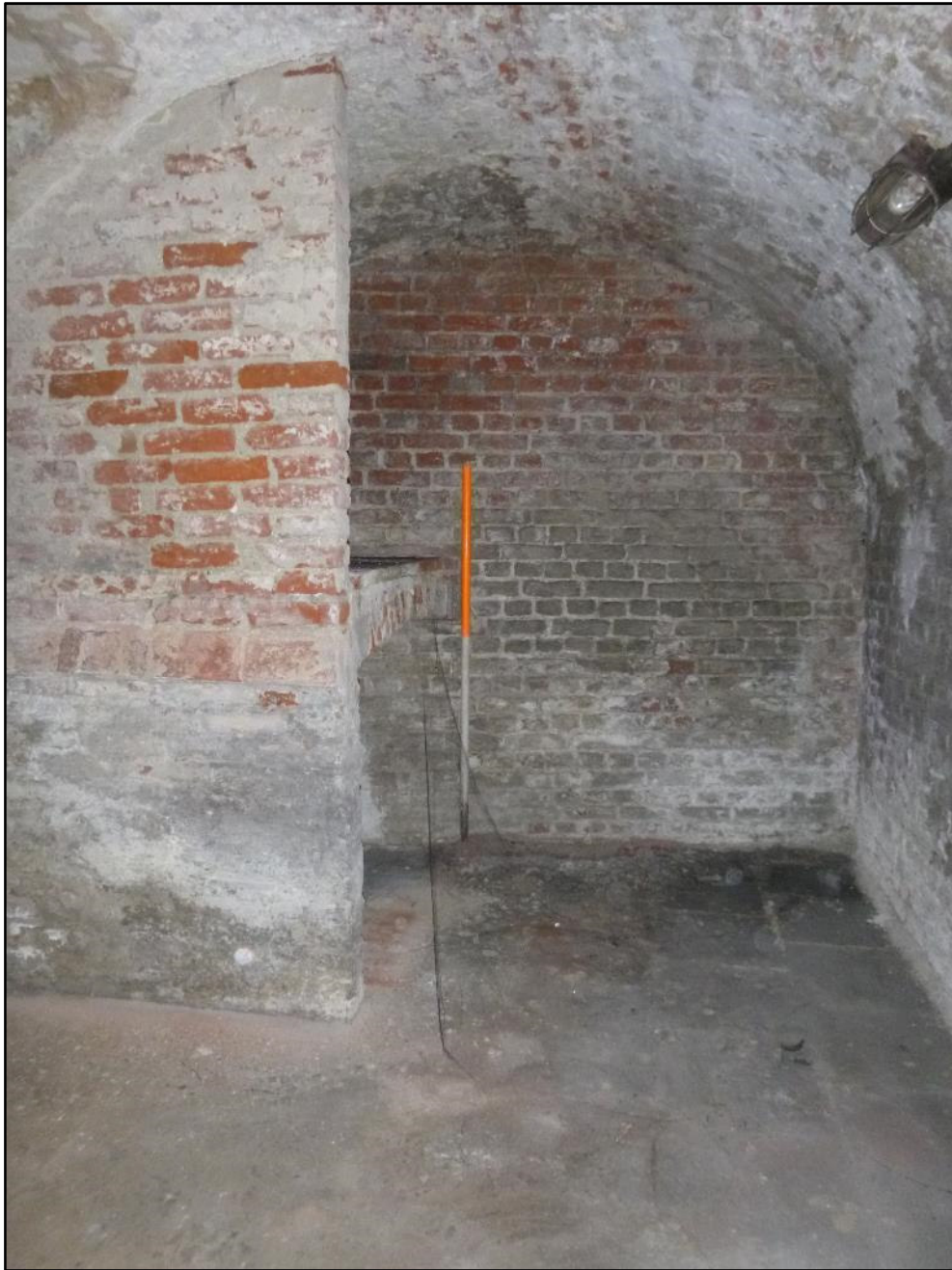
Figuur 16: Kelderruimte met bakstenen overwelling met nissen voor opslag (ABO nv)
