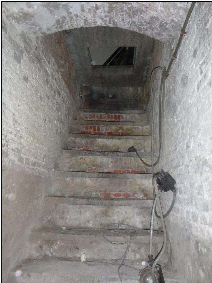
Figuur 14: Traptoegang tot de kelderverdieping (ABO nv)
