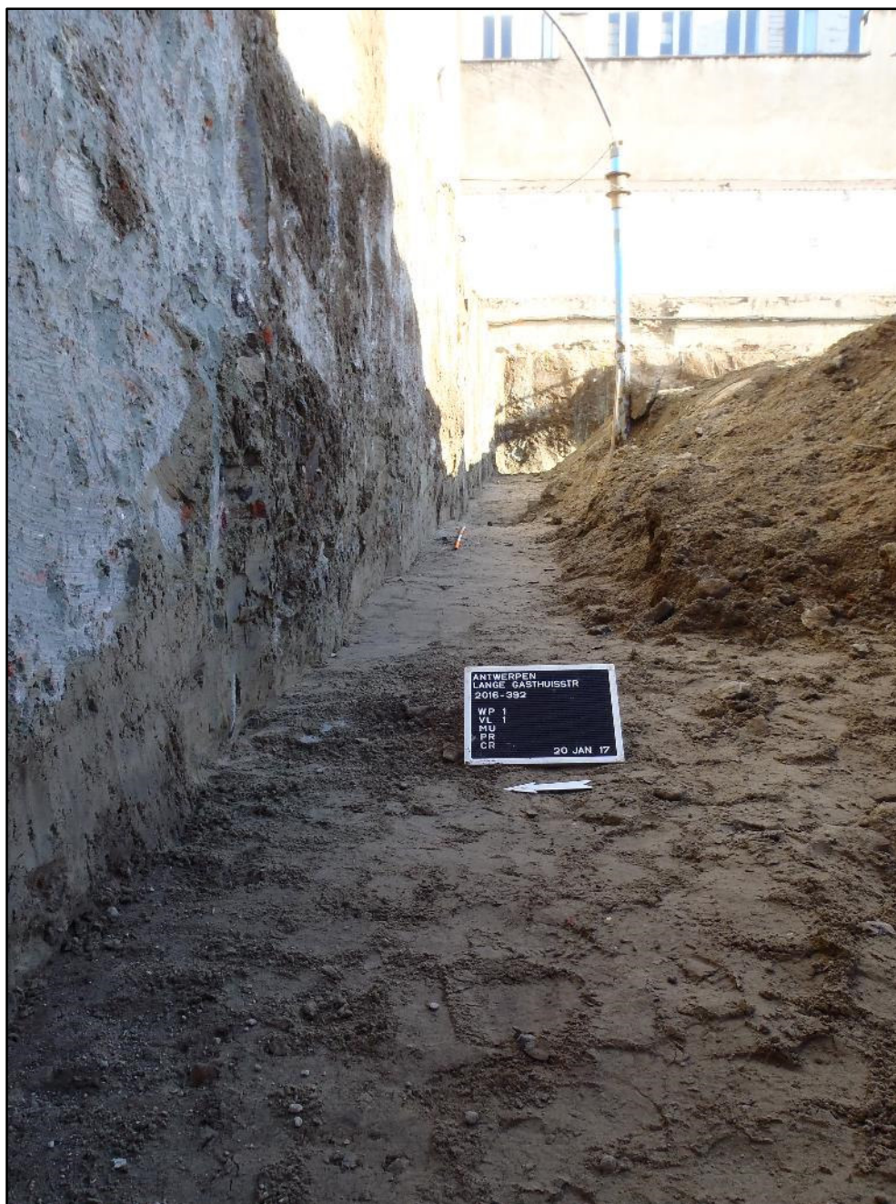
Figuur 40: Begeleiding uitgraving Soilmixwanden (ABO nv)
