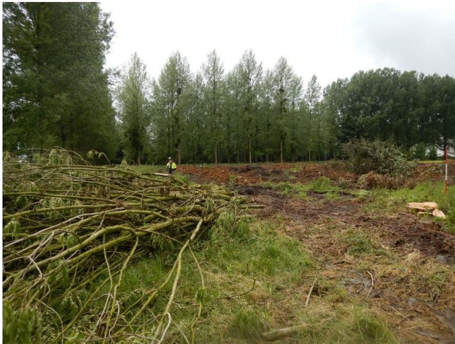
Fig. 62 : fotografische opname van de aanleg van een sleuf
