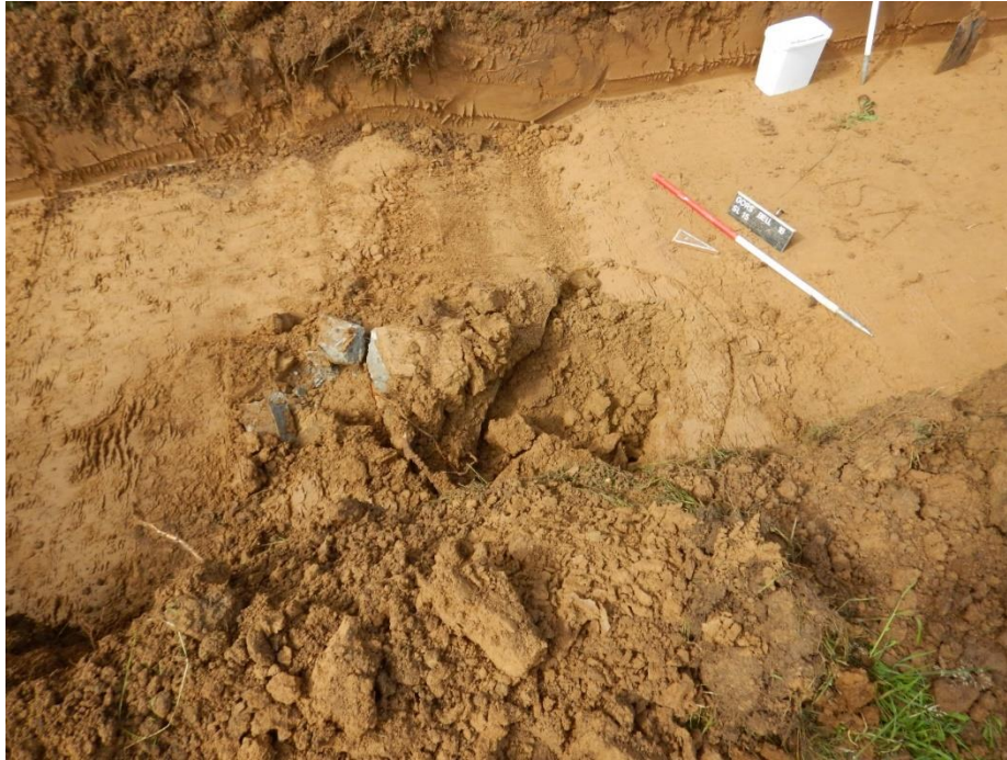
Fig. 74: fotografische opname van een ontstronkingskuil met betonbrokken in sleuf 15
