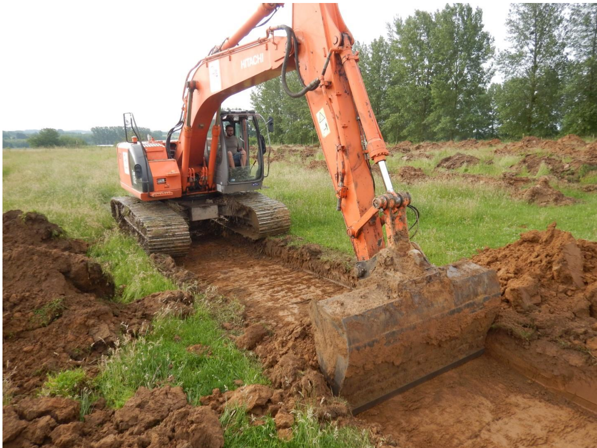
Fig.61.: fotografische opname van de aanleg van een sleuf
