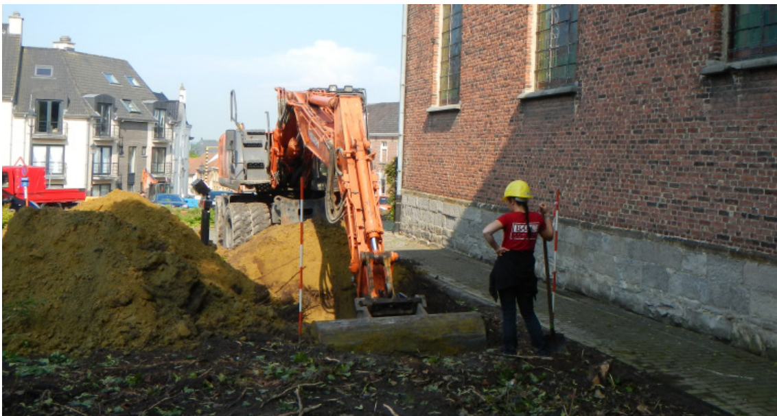
Figuur 34. Sfeerbeeld tijdens de aanleg van proefput 4.
