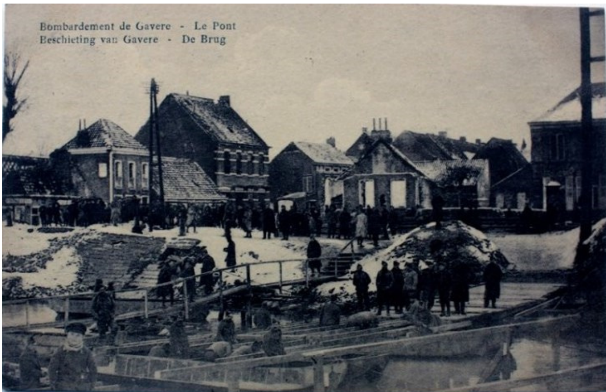
Figuur 21. Zicht op de vernielde brug met pontons die worden opgebouwd. 12
