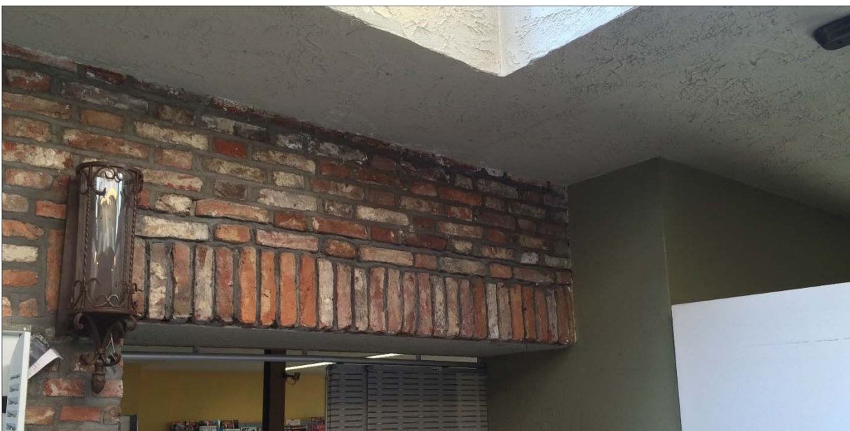
Figuur 17: Foto van de binnenmuur met herbruikte, oude bakstenen met grote afmetingen.
