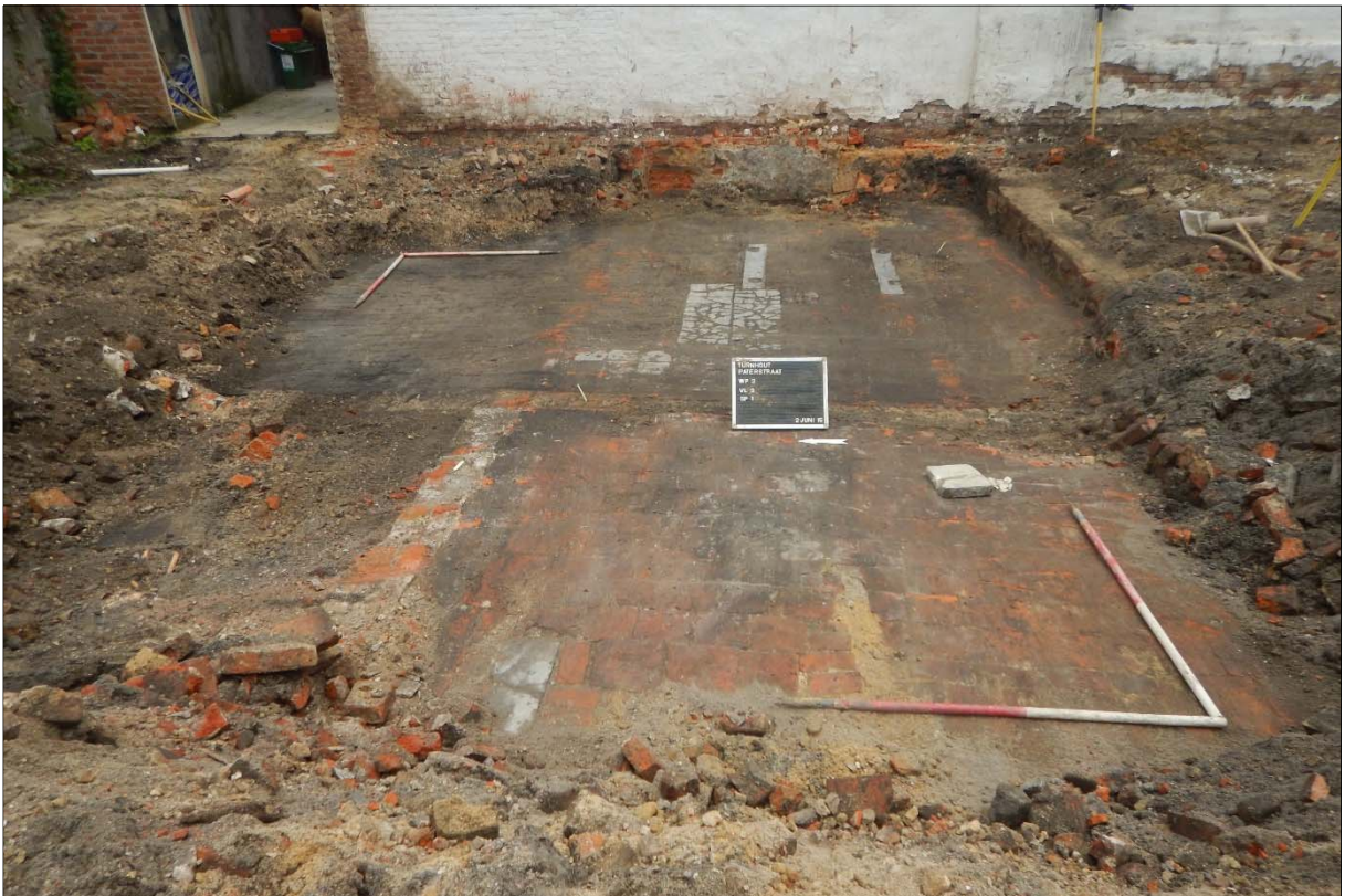
Figuur 31: Vlakfoto van de vloer in proefput 3. Bovenaan zijn de twee evenwijdige natuurstenen blokken die in de vloer verwerkt zaten zichtbaar. 56
