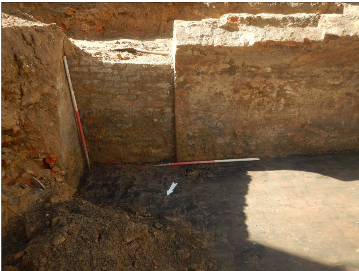
Figuur 19: Zicht op de zuidelijke muur van de kelder (S1.8) in proefput 1 met de dichtgemetselde doorgang. 39
