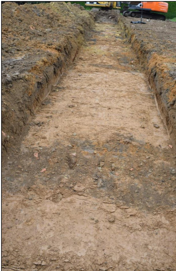
Afb. 16: Sleuf 1 met lagen en greppels opgevuld met recent bouwpuin.
