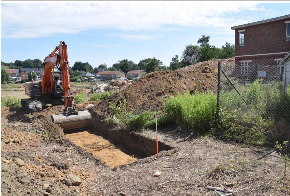
Fig. 2.3: Het graven van sleuf 16 doorheen de verlegde grondhoop.
