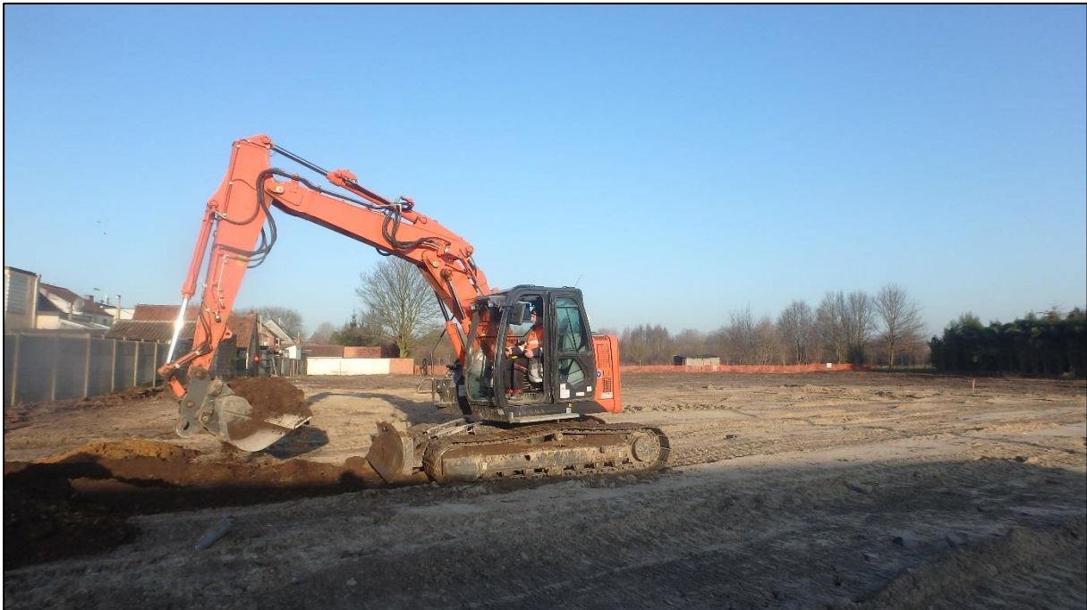
Figuur 17: het aanleggen van de sleuven
