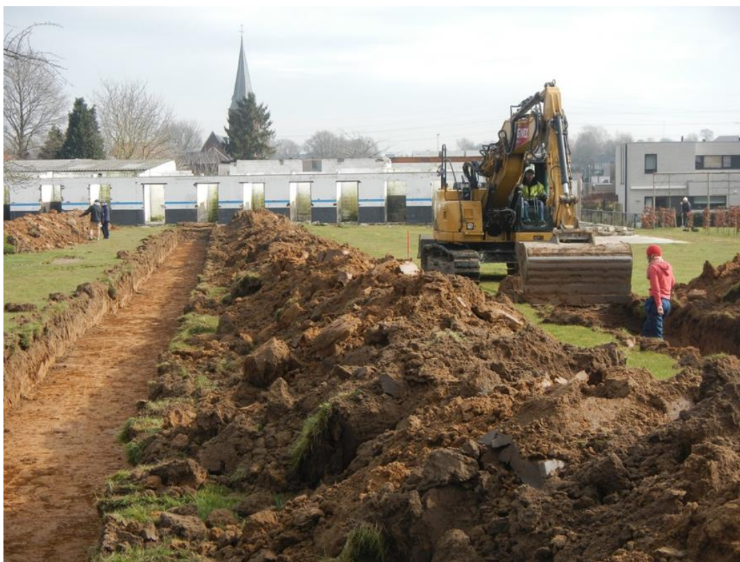
Afbeelding 9: Impressie van het aanleggen van de sleuven en links boven een aantal leden van Lin in het Groen die de storthopen inspecteren.
