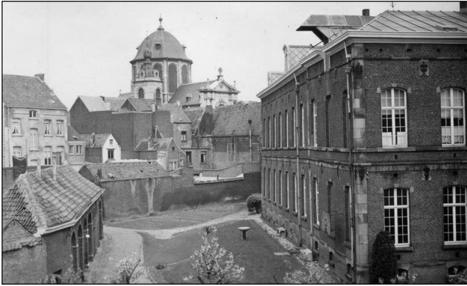
Afb.25: Foto met zicht op de achtergevel van het bejaardenhuis, 1958 (Bron: Stadsarchief Mechelen SME001008433).
