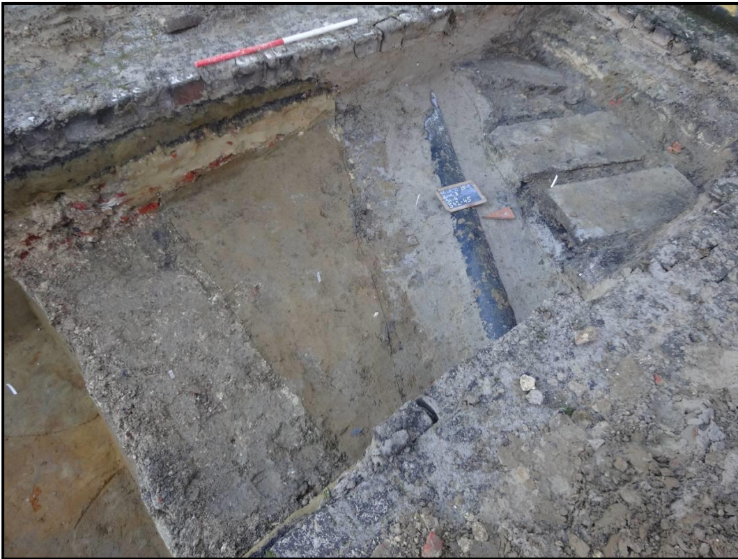
Figuur 22: Zone in het zuiden van sleuf 4 met links de mogelijke (povere) resten van de 17 de -eeuwse kazerne. In het midden een recente riolering en rechts dekstenen van een oudere riolering.
