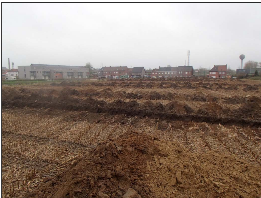
Figuur 15: De aangelegde sleuven
