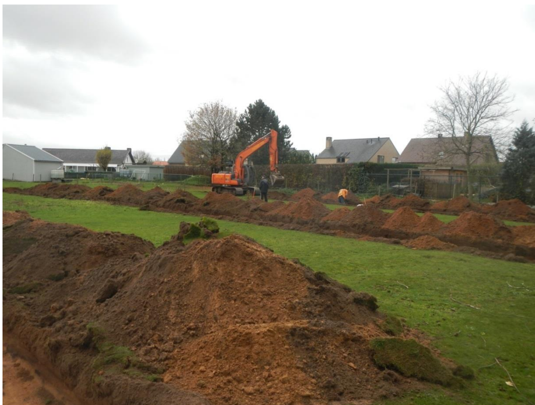
Afbeelding 8: Impressie van het aanleggen van de sleuven.
