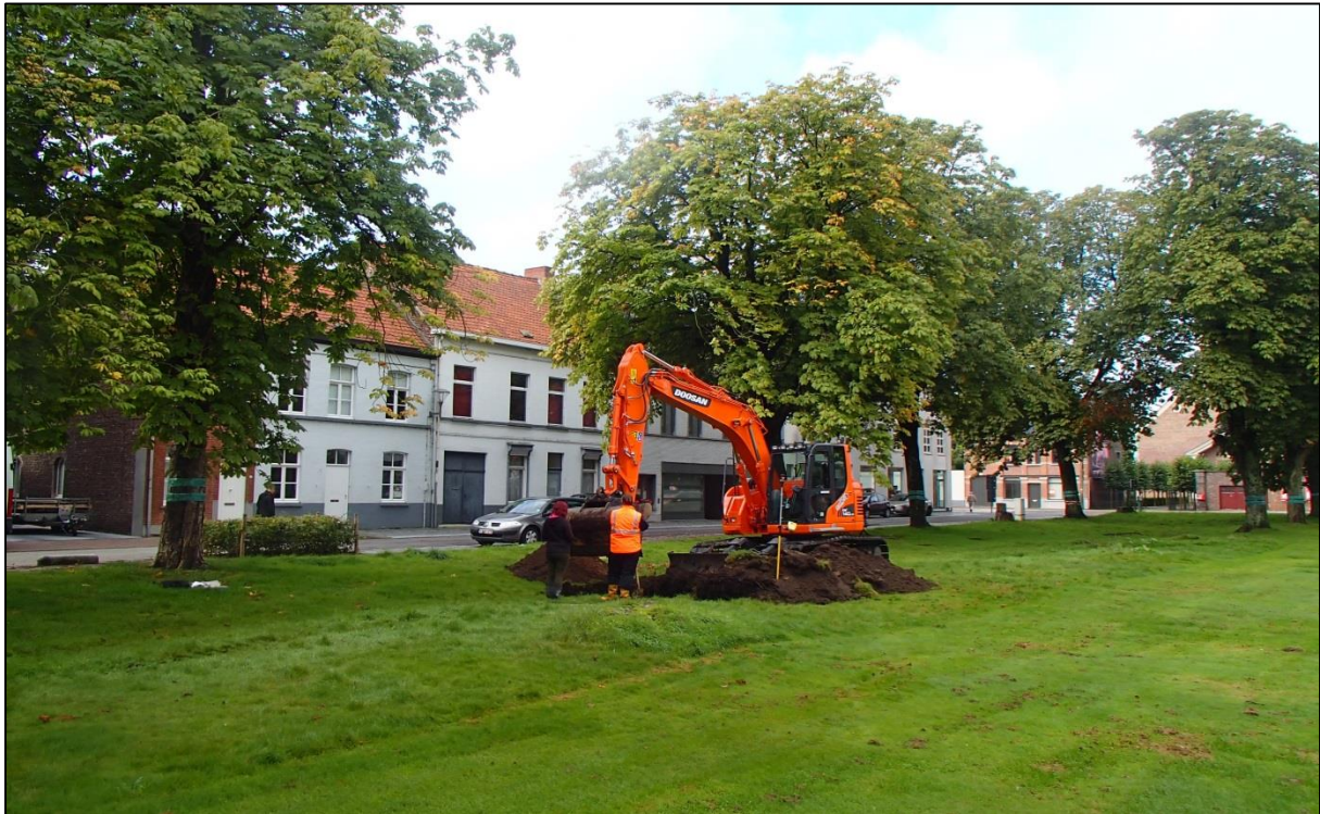
Figuur 26: De machinale aanleg van werkput WP04
