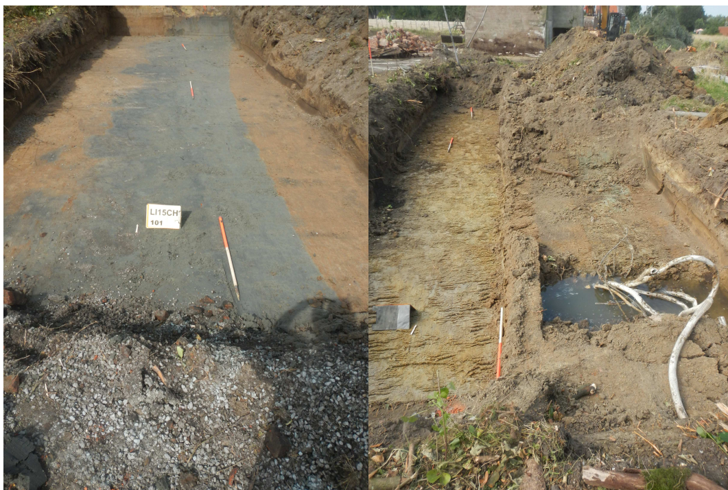
Afbeelding 23: De nutsleidingstuf in WP11 en mazoutleidingen in WP12.
