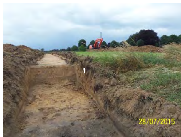
Figuur 6: Zicht op het talud (1).
